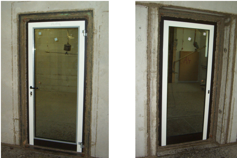
Bild 1 Elementansichten (Fotos erstellt vom ift-Schallschutzzentrum)
